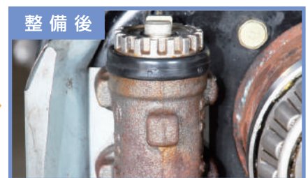
整備後 ホイール・シリンダから液漏れがなく、ゴム部品が新品の状態
